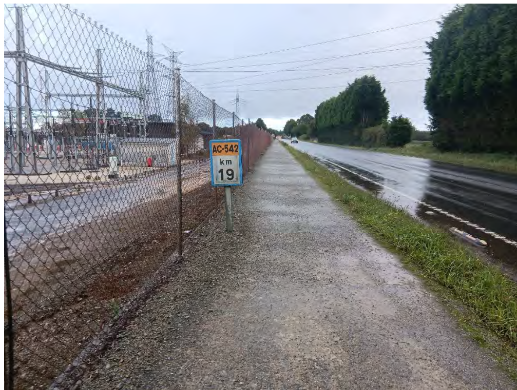
Estado general del pavimento tipo suelo cemento de la senda
