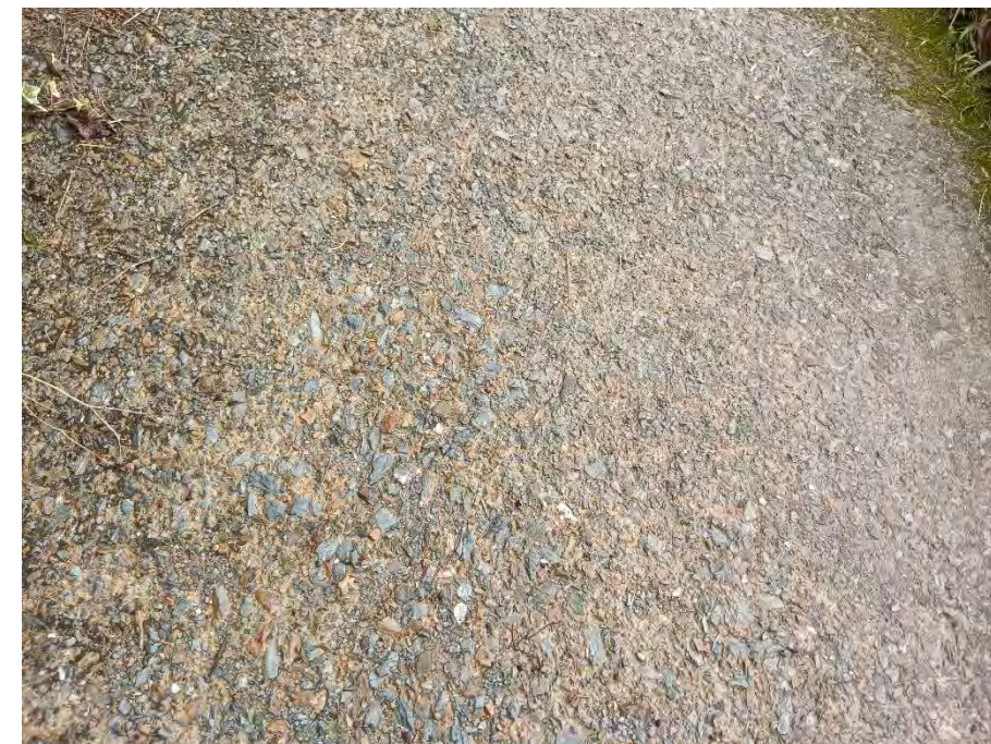
Detalle del estado del pavimento tipo suelo cemento de la senda
